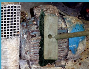
Во время очистки
